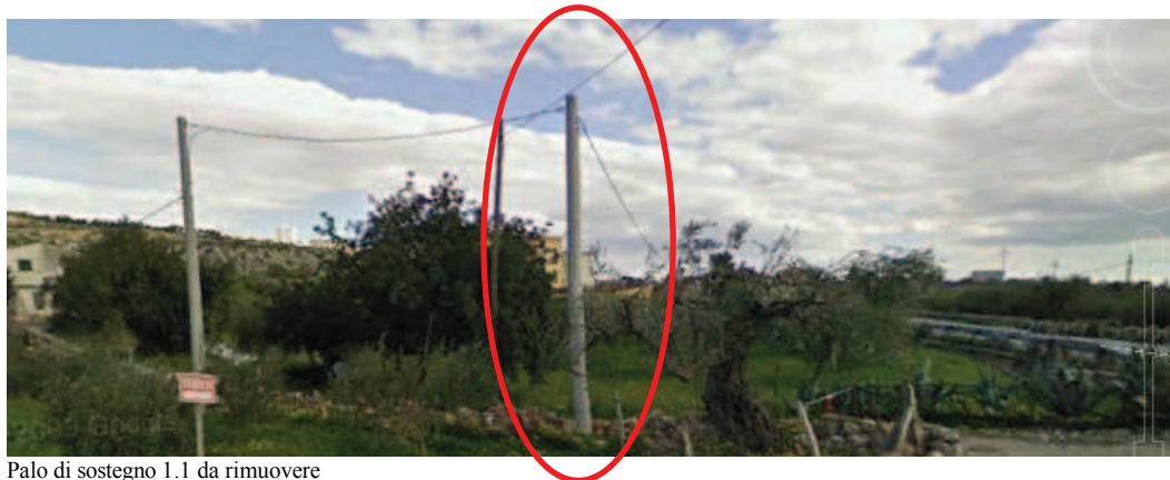
Palo di sostegno 1.1 da rimuovere
