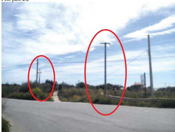
Foto palo 2.1 da sostituire - Foto palo 2.b da rimuovere
