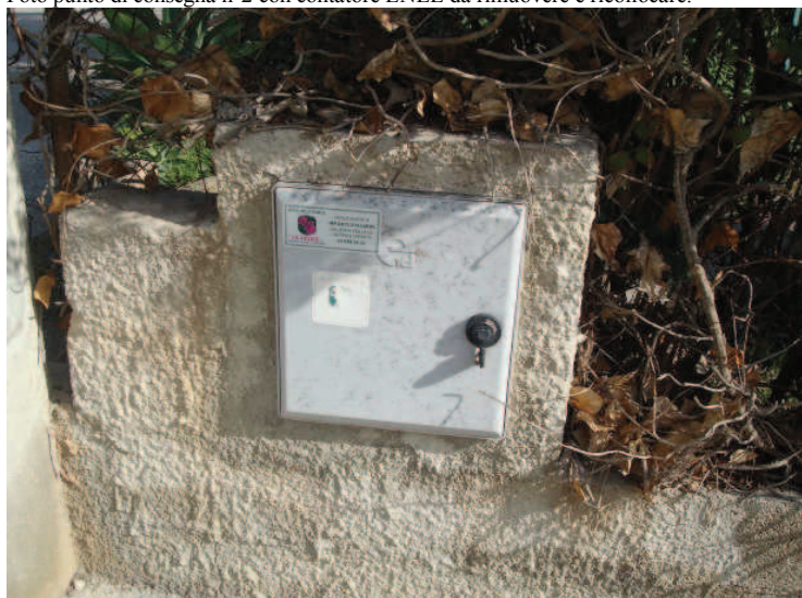
Foto particolare contatore n°2 da rimuovere e da ricollocare a tergo del tracciato
