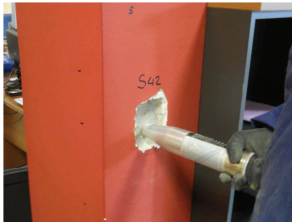
Figura 7. Fasi di esecuzione dell'indagine sclerometria.
