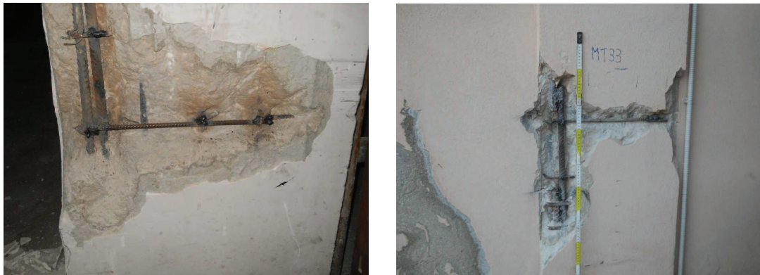
Figura 8. Fasi di prelievo dei saggi d'acciaio e ripristino delle armature.
