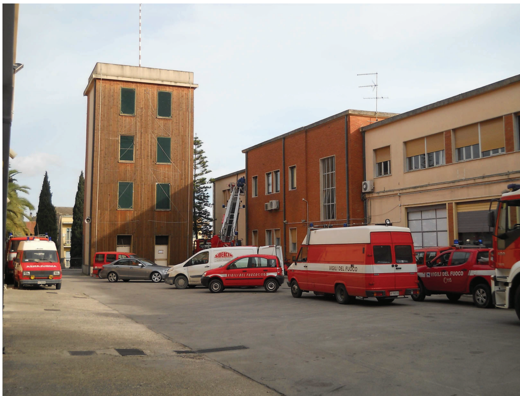
Figura 2. Vista generale del cortile antistante l'accesso della caserma (CORPO A1-A3).
