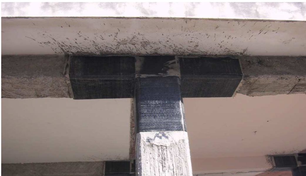
Esempio di confinamento nodo in FRP
