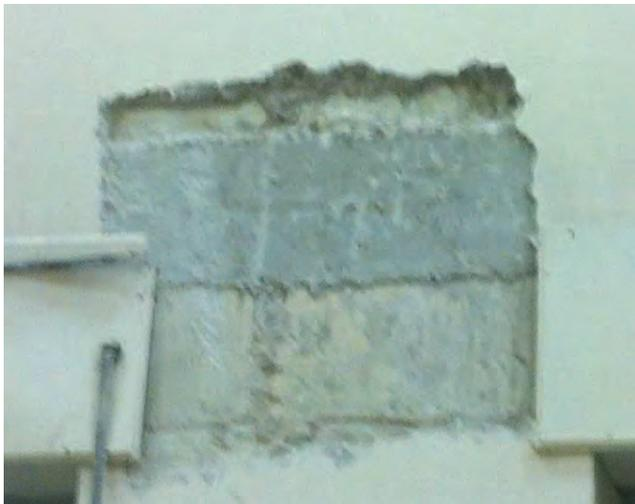
*Figura 18: saggi condotti all'interno della palestra da cui si evince la presenza di un architrave tra le finestre.*
