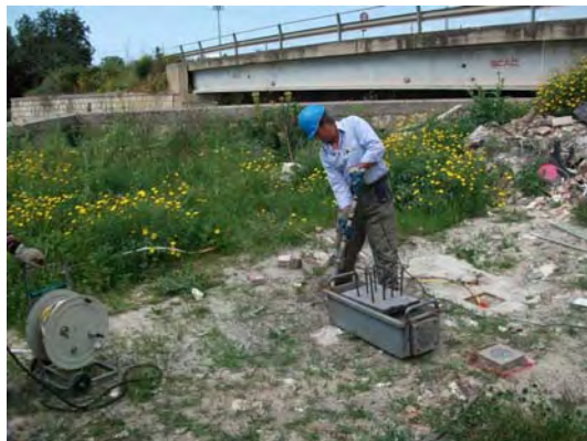
DHS5B - ENERGIZZAZIONE S+
