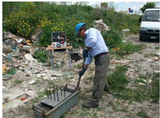
DHS5B - ENERGIZZAZIONE S-
