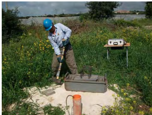
DHS1B - ENERGIZZAZIONE S+
