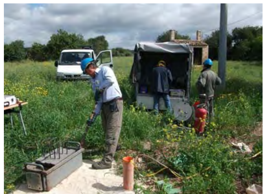
DHS1B - ENERGIZZAZIONE S-
