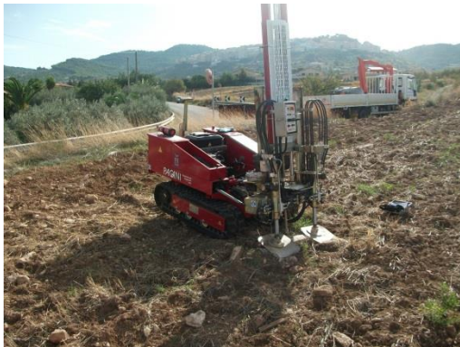
SP 7 dal km 8+600 al km 10+700: prova penetrometrica DPHS P1
