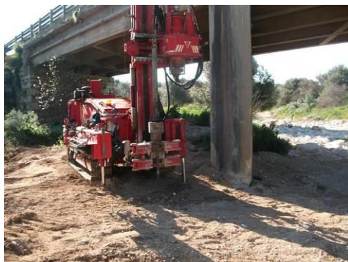
Miglioramento sismico del Ponte Biddemi:
