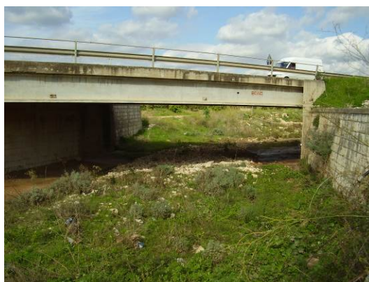
Alveo del Torrente Salsia al km 2+750
