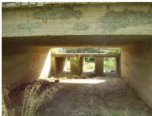
Ponte sull'alveo del Torrente Graffetta
