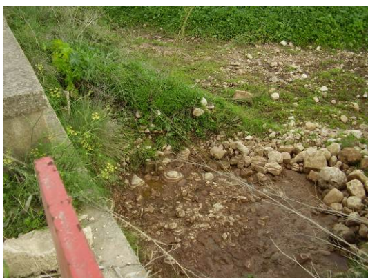
Forme di cavitazione e ruscellamento concentrato nei pressi del Km 3 circa
